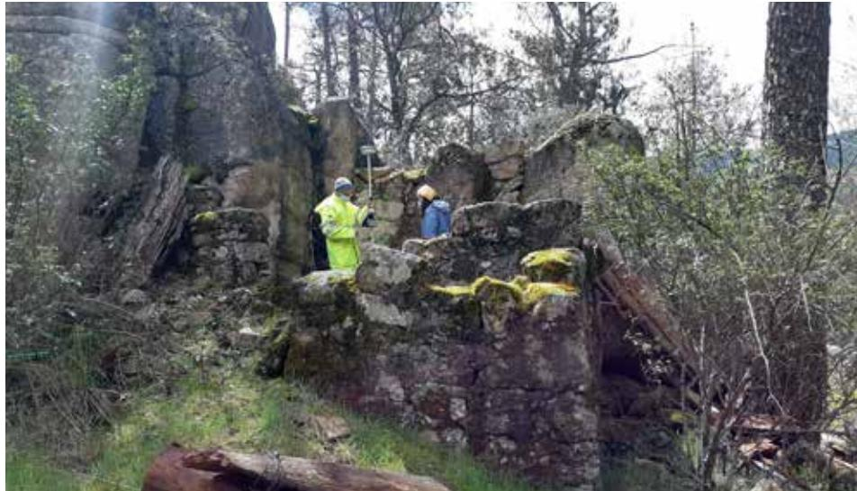
Figura 98. “Casita” de la Zona B del destacamento penal de San Román. Es una de las estructuras mejor construidas de las documentadas hasta la fecha. Tiene muros de mampostería bien construidos, estancia principal con chimenea y atrio.
